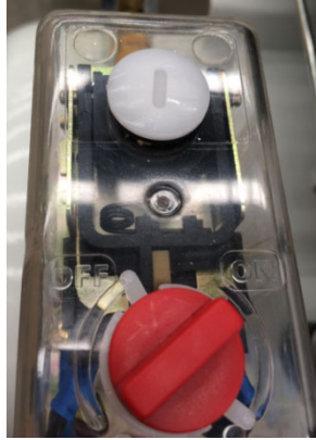
Переключатель управления давлением в положении ВКЛ.
